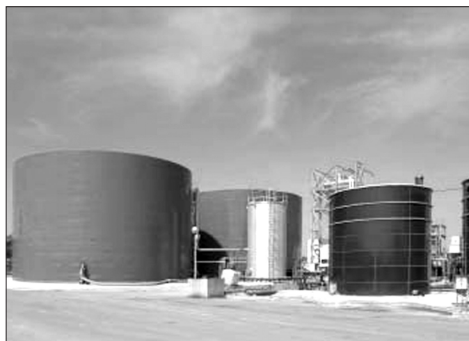
Planta de tractament de purins i cogeneració d'energia elèctrica de Juneda (Garrigues).
